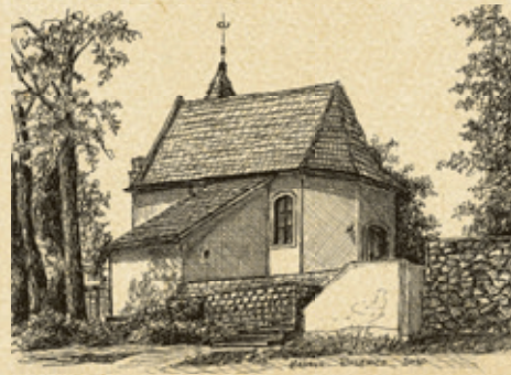
Kaplica zamkowa od strony południowej
