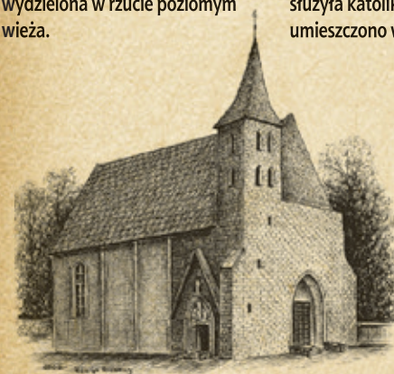
Widok kaplicy od strony północnej
