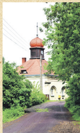
Pałac – fragment elewacji ogrodowej
