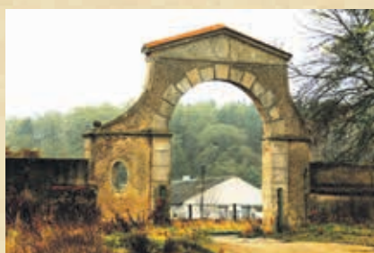
Zabytkowa brama wjazdowa – widok od strony dworu
