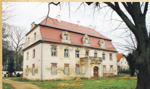
Front pałacu (stan obecny)
