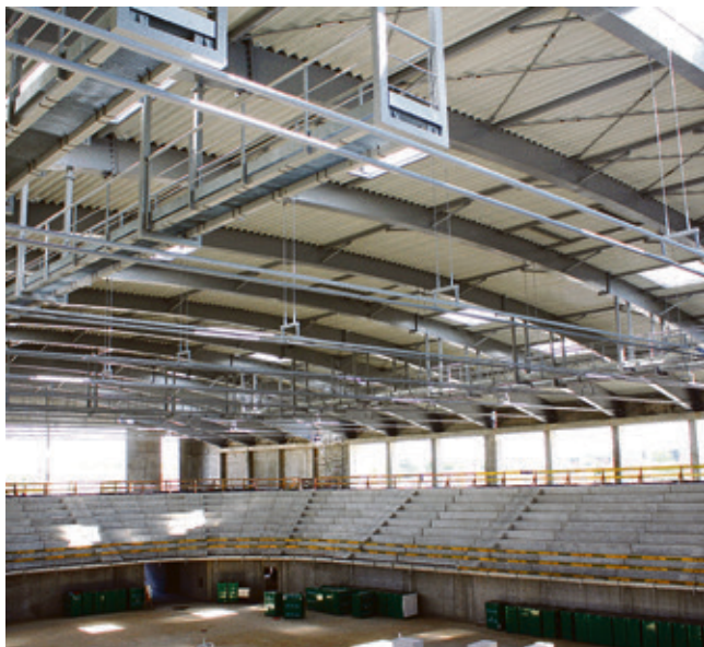
Została już zakończona konstrukcja dachu, a także prace związane z realizacją stanu surowego otwartego
