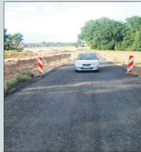
Prace zostały rozłożone na kilka etapów
