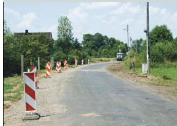
Modernizacja ma polegać na tzw. naprawach cząstkowych, czyli łataniu dziur w drogach, a zwłaszcza tych, które zagrażają bezpieczeństwu ruchu drogowego
