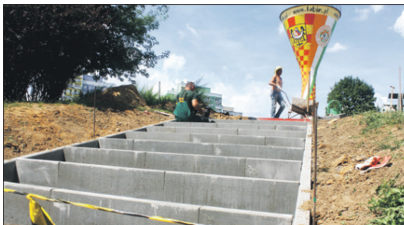
Lubiński magistrat nie zapomniał jednak o Pawiej i już ruszył remont schodów przy budynku nr 66. Przekładane są również stopnie istniejących już schodów przy budynku 52
