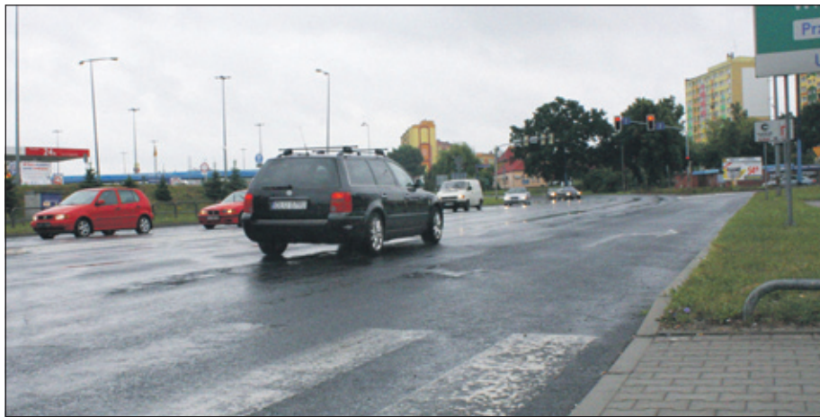
Przebudowa ulicy obejmie dwa skrzyżowania: z ulicami Wrocławską i Sikorskiego
