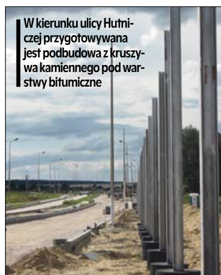
Drogowcy spodziewają się, że w połowie sierpnia uda się położyć pierwsze warstwy asfaltowe nawierzchni
