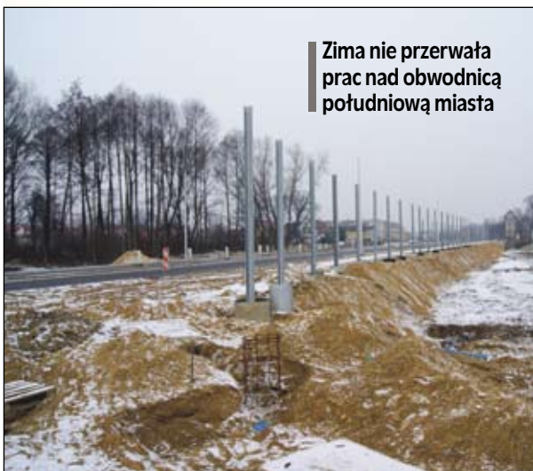
Wykonane zostały elementy (słupy) ekranów akustycznych
