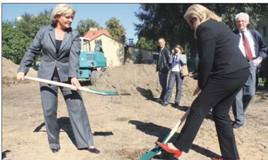
Pierwszą łopatę pod budowę drugiej części hospicjum wbito we wrześniu ubiegłego roku
