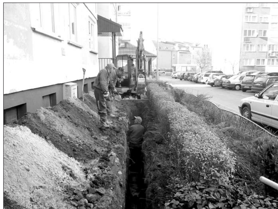
Trwają prace przy ulicy Kazimierza Wielkiego związane z wymianą sieci wodociągowej i przyłączy wody
