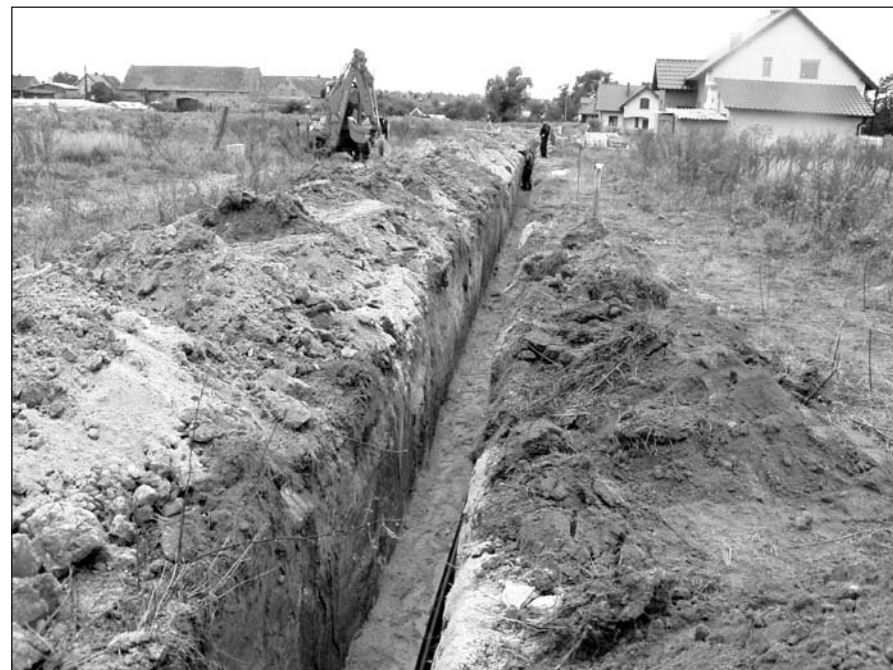
Zakończono prace wodociągowo-kanalizacyjne przy ulicy Małomickiej
