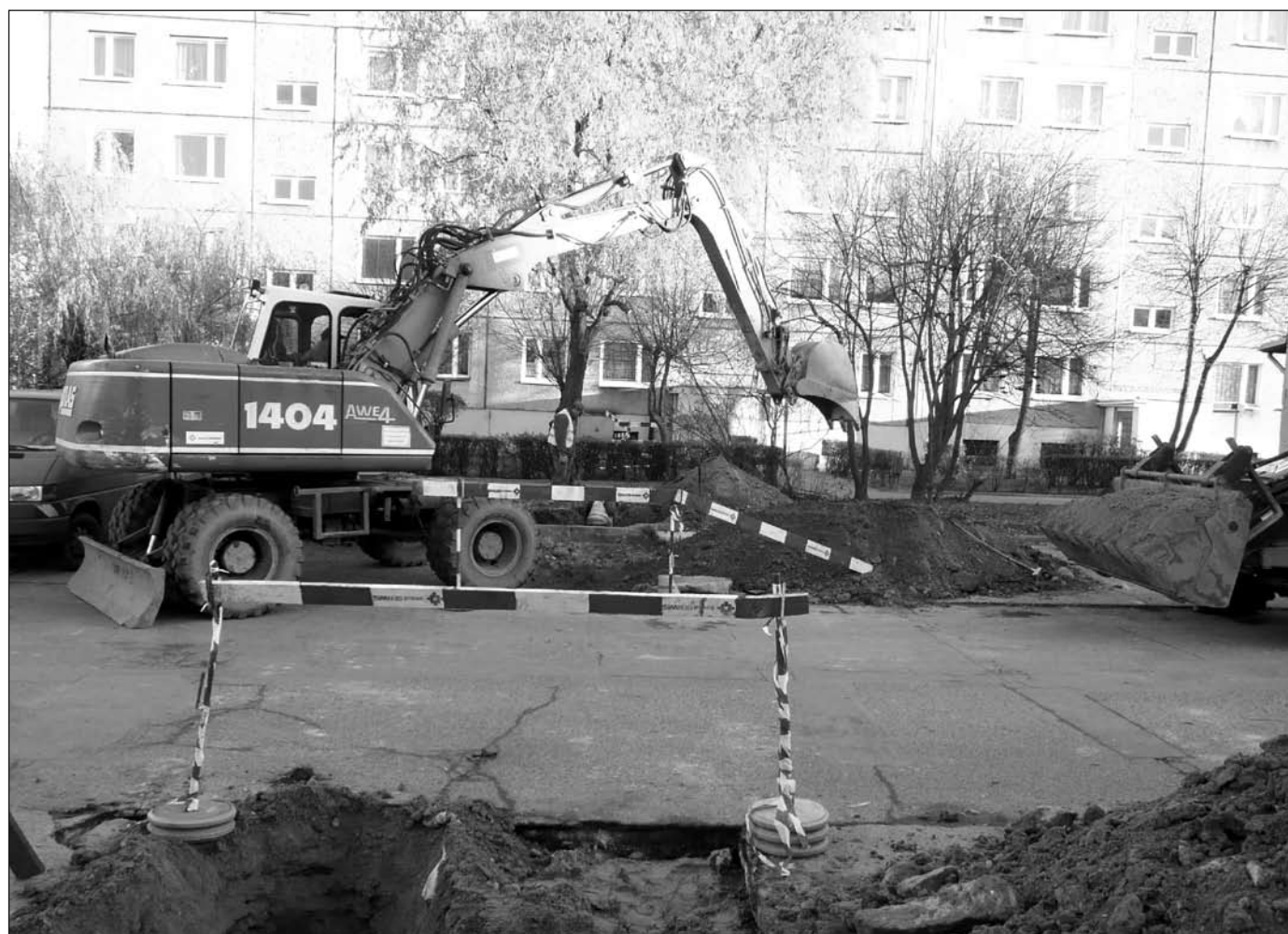
Przy ul. Gwarków kontynuowane są prace związane z przyłączami wodociągowymi
