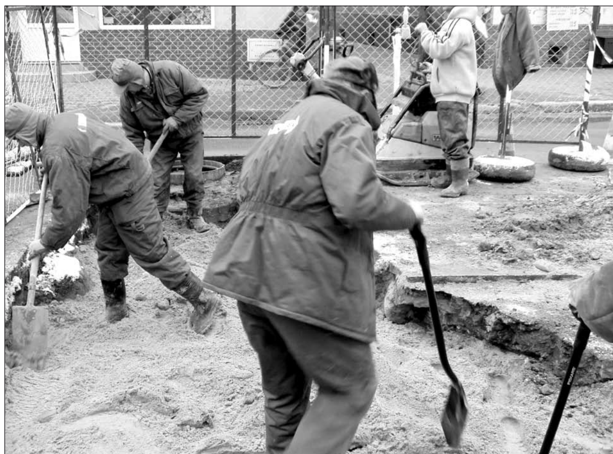
Przebudowa kanalizacji sanitarnej w pasie drogi wojewódzkiej w ulicy Marii Skłodowskiej-Curie
