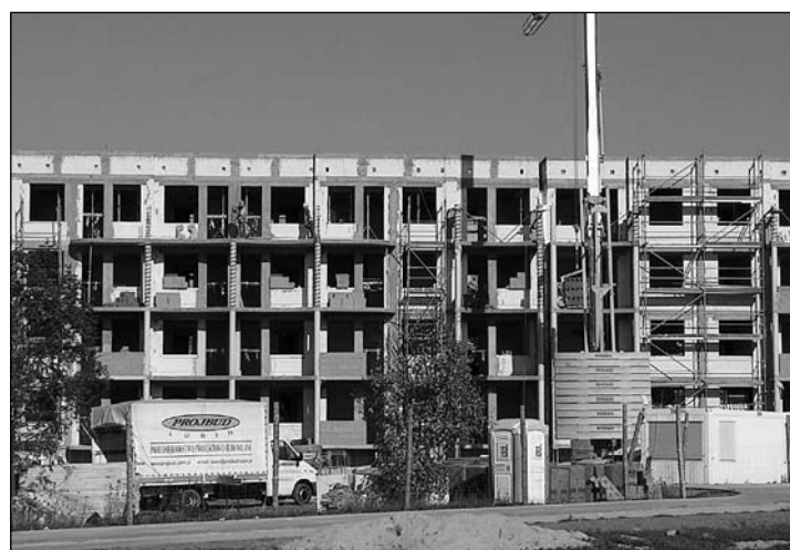
➤ Budowa przy ul. Wyszyńskiego (Przylesie)
