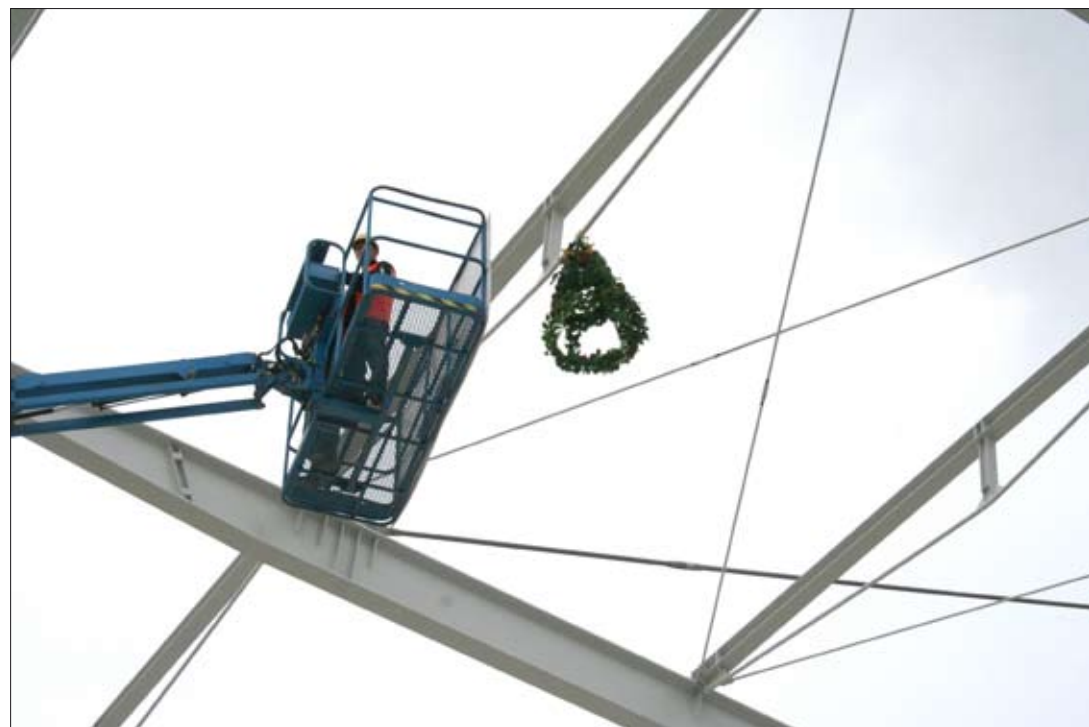
20 metrów nad ziemią zawisła symboliczna wiecha, która oznacza, że obiekt już wyższy nie będzie
