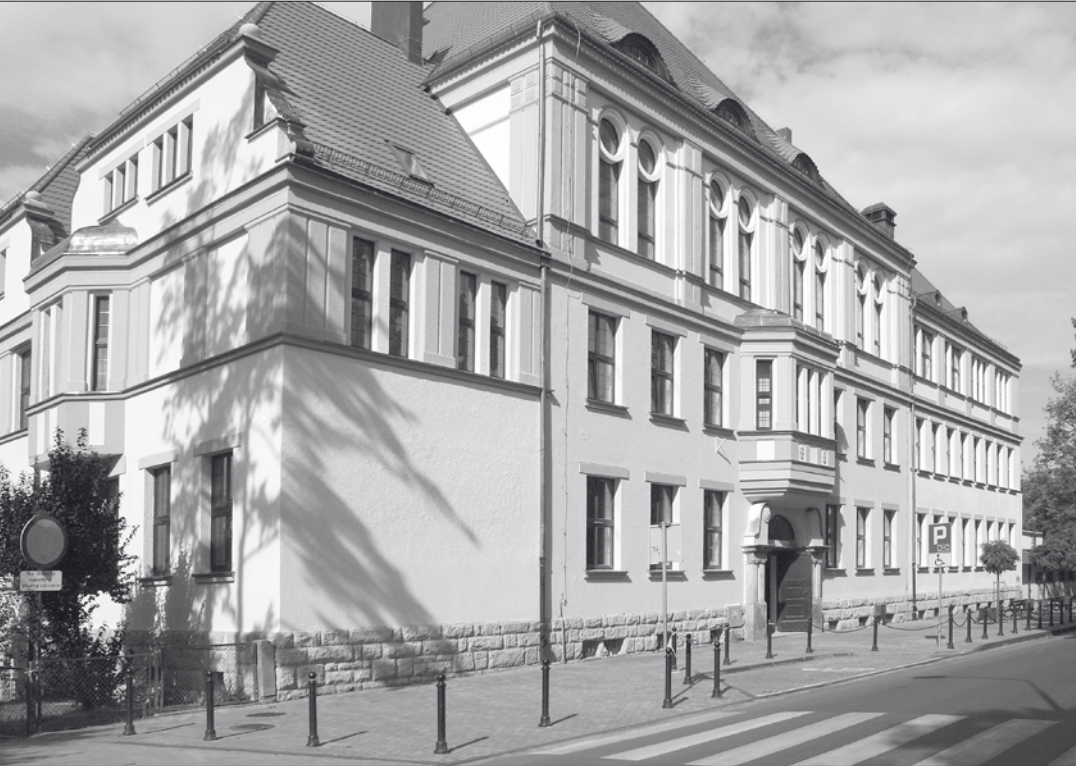
Od września licealiści uczyć się już będą w wyremontowanej placówce
