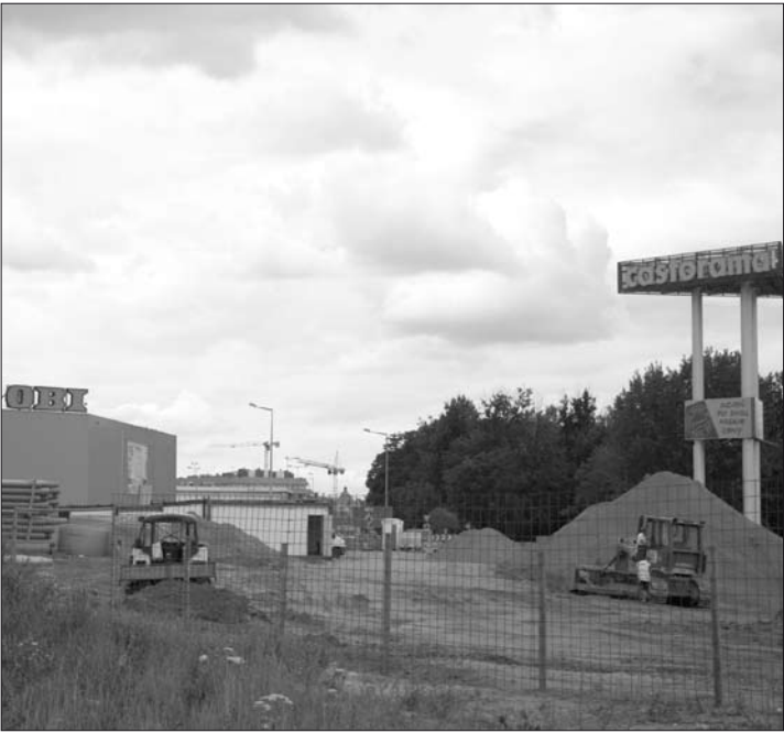
Na placu budowy między OBi a Castoramą praca wre
