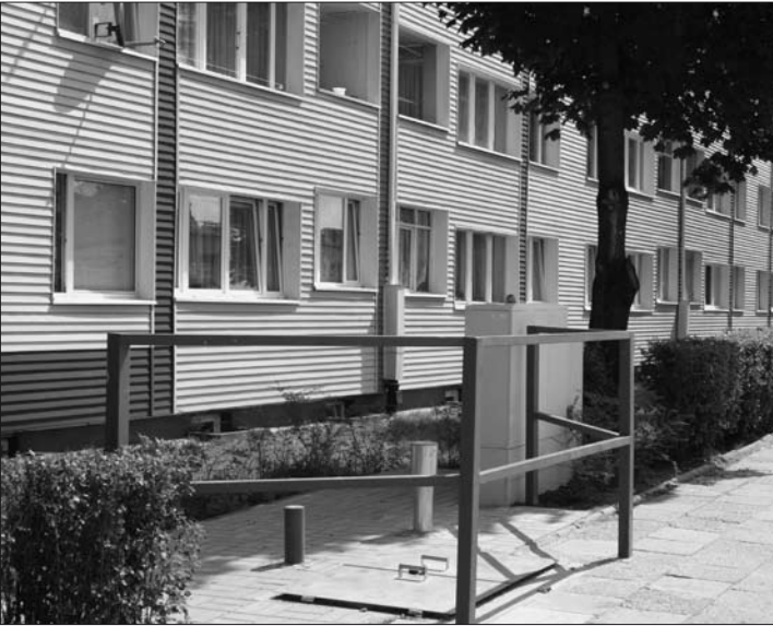
Przepompownia ma być zlikwidowana w przeciągu najbliższych 2-3 lat
