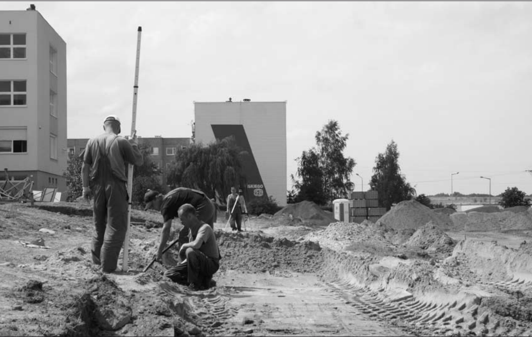
Przy Gimnazjum nr 3 trwają prace budowlane, już wkrótce powstanie tu kompleks sportowy
