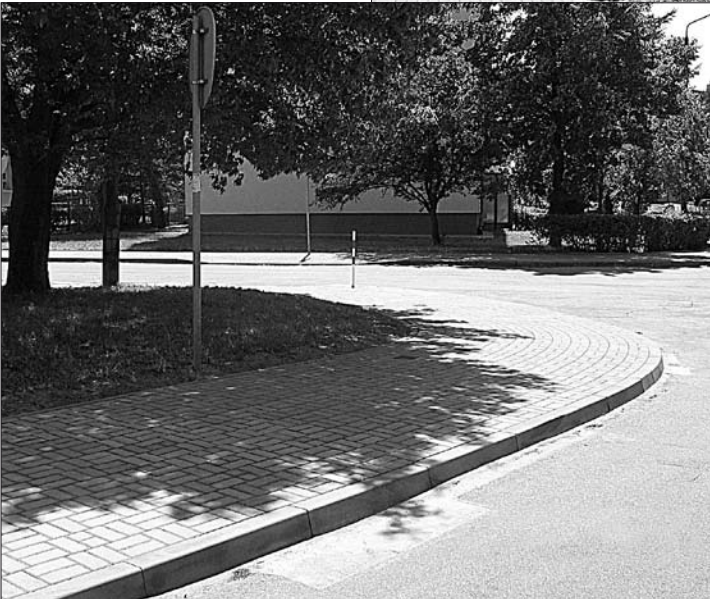
Przy Legnickiej wykonano około 110 metrów nowej nawierzchni. Przebudowa chodnika kosztowała Urząd Miejski 130 tys. zł
