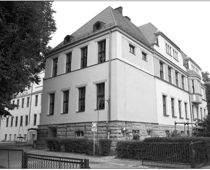
Jedna strona budynku już jest gotowa, z drugiej wciąż trwają prace remontowe
