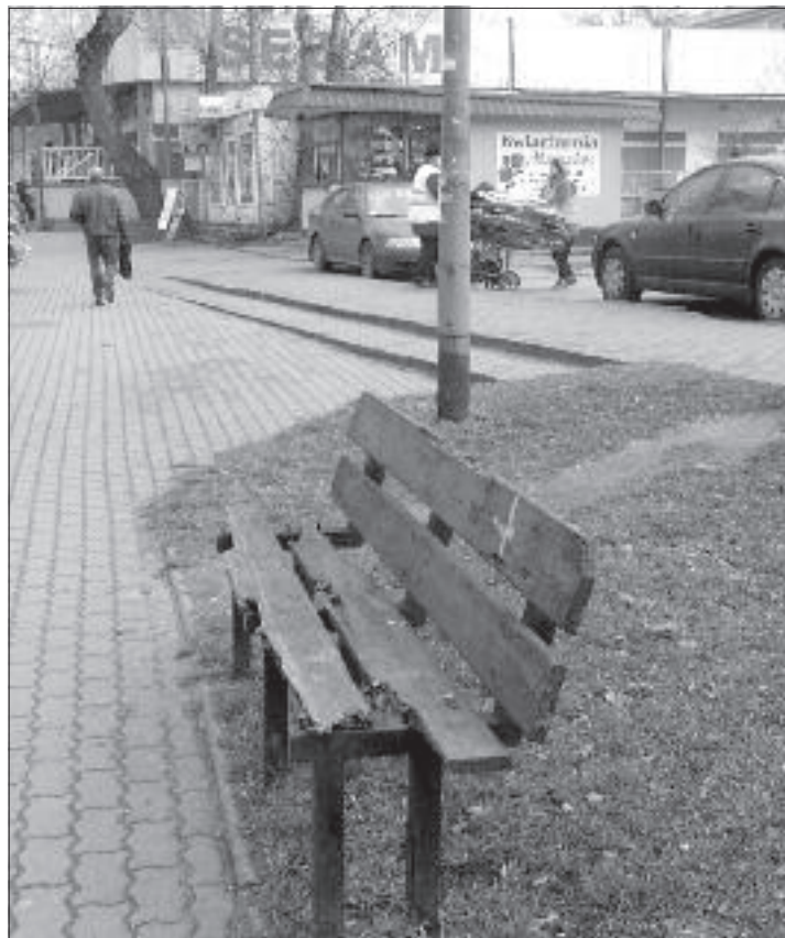
Zniszczone ławki na ulicy Śląskiej prawdopodobnie zostaną wymienione
