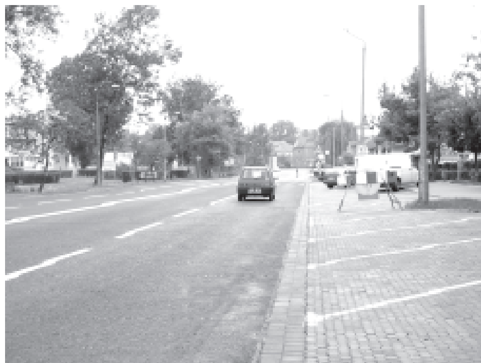
Ulica Sikorskiego po remoncie
