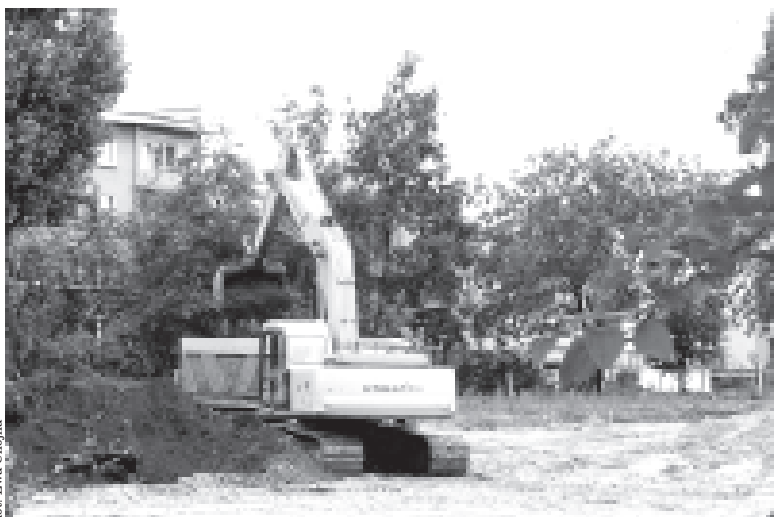
Plac budowy nowej przychodni OMP przy ul. Słonecznej w Lubinie
