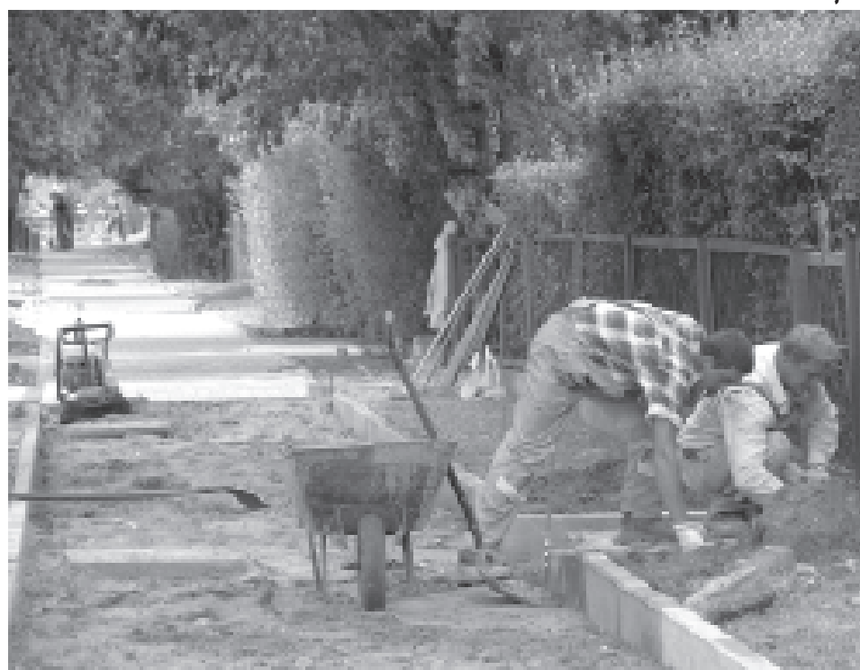
Remont chodnika przy ul. Marii Skłodowskiej-Curie
