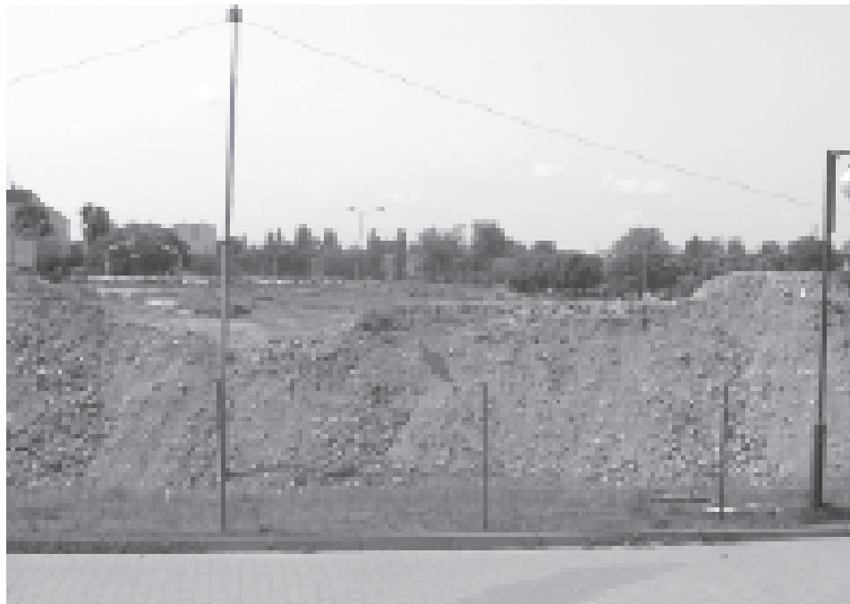
Teren budowy Galerii Cuprum w Lubinie
