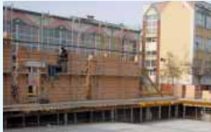
Trwa budowa basenu przy Gimnazjum nr 4.
