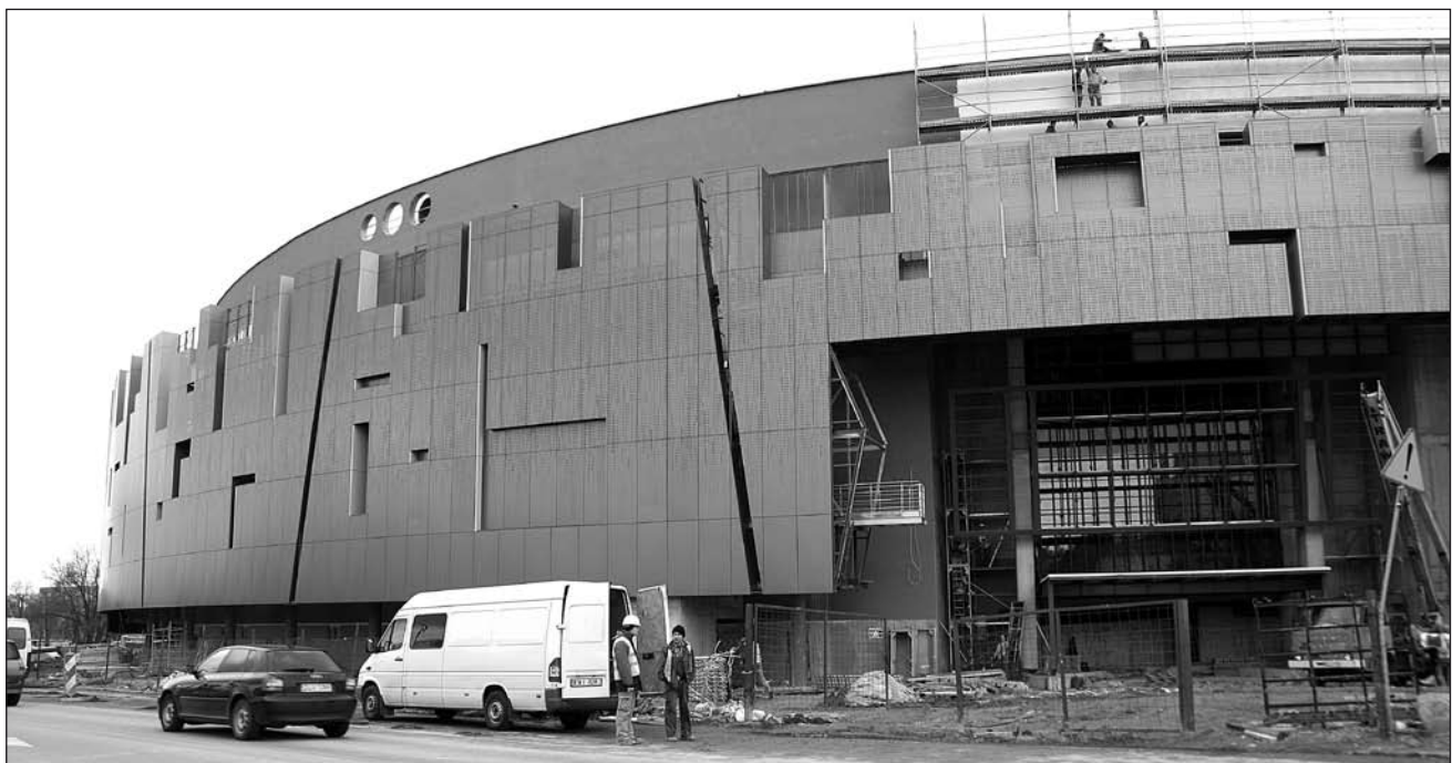
Pierwsi klienci zrobią zakupy w lubińskiej galerii już w maju. Na razie trwa budowa
